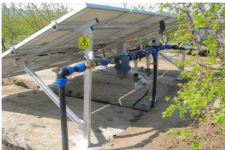
Fig.3.4 Vedere panou fotovoltaic si retea de irigatii pomparii la o plantatie de pomi fructiferi [203, 204]
