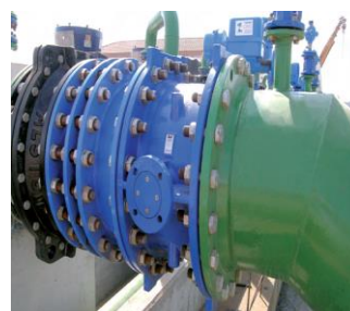
Vana fluture cu dublu excentric
