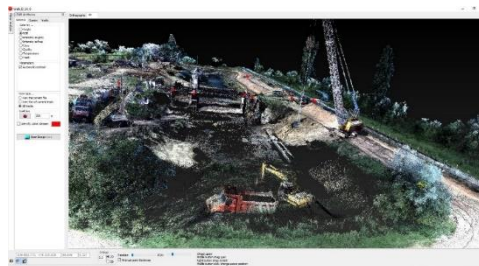
Fig. 4.99 Renovarea Ecluzei din Sânmihaiu Roman, scanare 23.07.2019 (Șmuleac 2019)
