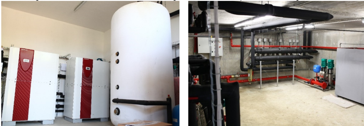
Figura 2 – Pompe de căldură și distribuitor foraje
