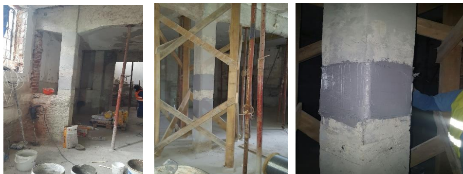
Figură 15. Stâlpi și grinzi consolidați cu Kerakoll Geosteel 200 [48]
