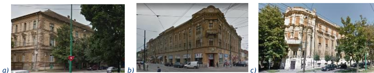
Figură 17. Clădirile investigate: a) Palatul Arheducelui; b) Palatul prințesei Mirbach; c) Palatul Karl Kunz [49]
