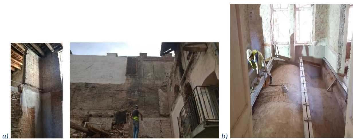
Figură 13. Consolidări la nivelul: a) pereților din zidărie; b) bolților din zidărie
