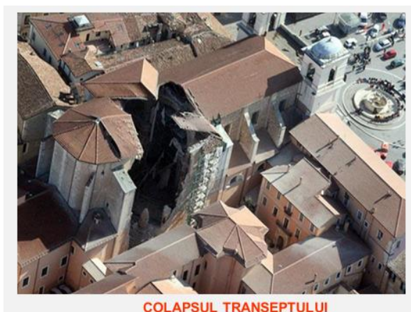
Figură 64. Exemplificare a efectelor cutremurului asupra Bisericii Sant Agostino, L'Aquila, Italia (extras din curs)
