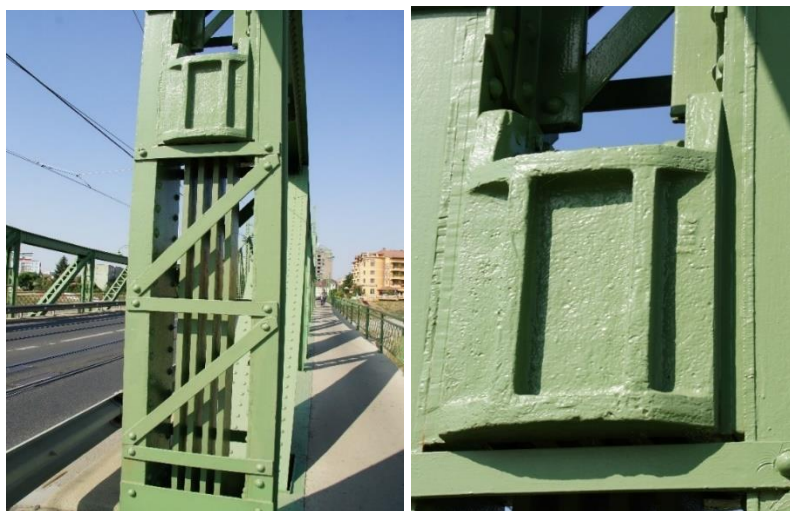
Figura 28. Consolidare pendulul mare
