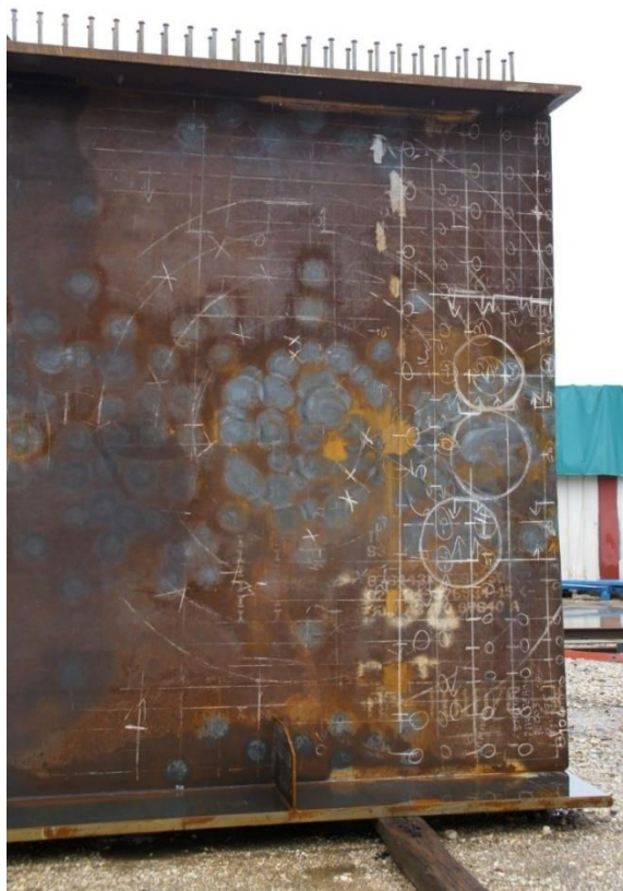
Fig. 72. Imagine cu procedeul utilizat în Franța la remedierea unei inimi cu deformăție mare
