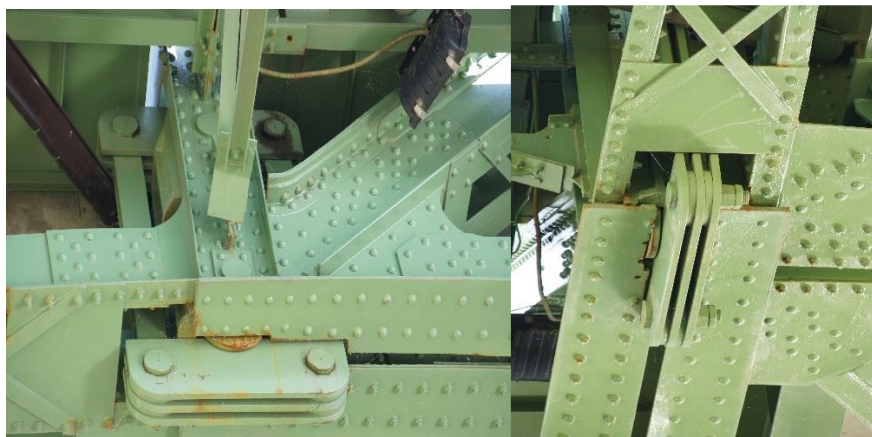
Figura 27. Sistemul de consolidare folosit la pendulul mic.
