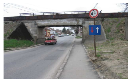
Fig. 52. Viaductul N. Andreescu
