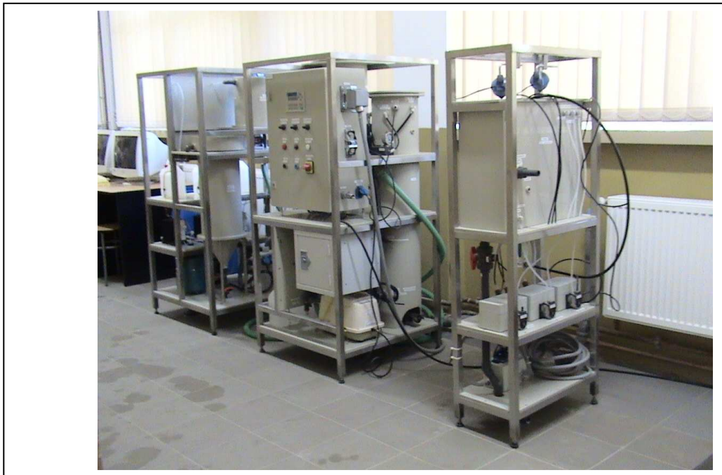
Foto 2 Statia pilot ZW – 10 pentru tratarea apei
