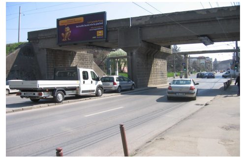
Fig. 54. Viaductul Gheorghe Lazăr
