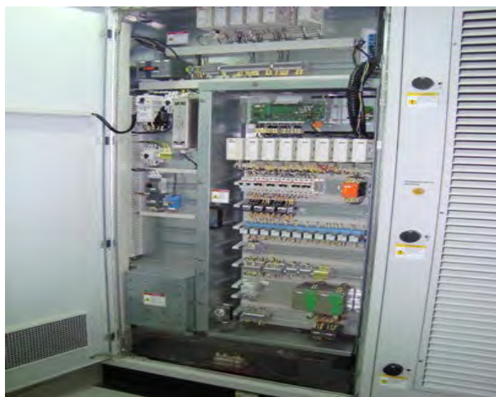
Figura 3.1.2.13 Vedere asupra părții de comandă și automatizare la ACS 5000 (fotografie publicată cu acordul S.C. Kronospan S.A. Sebeș).
