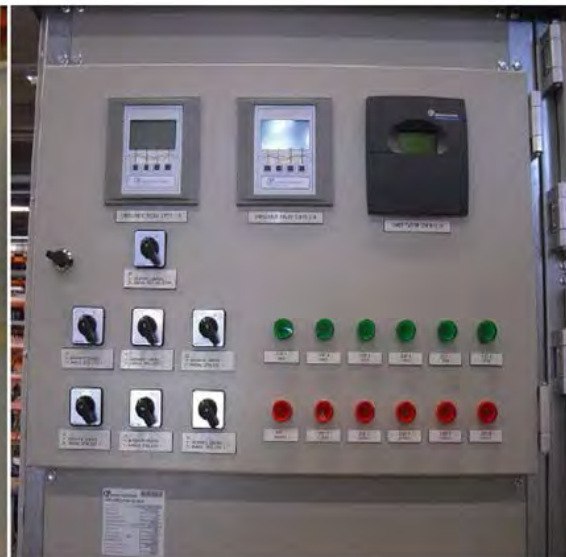
Figura 3.2.2.14 Controlerul digital al factorului de putere.
