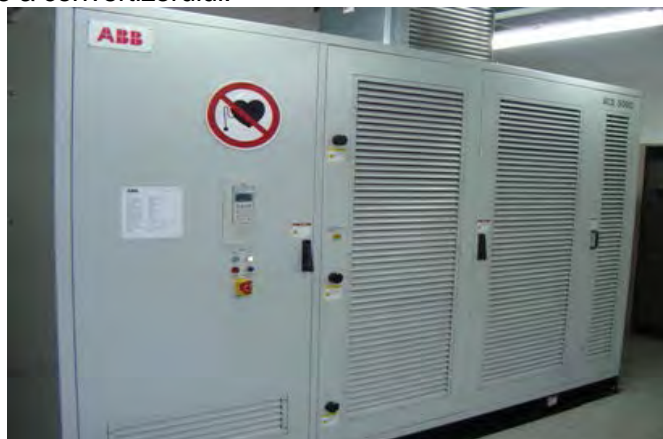
Figura 3.1.2.11 Dulapul convertizorului de tip ACS 5000 – 2100KVA (fotografie publicată cu acordul S.C. Kronospan S.A. Sebeș)
