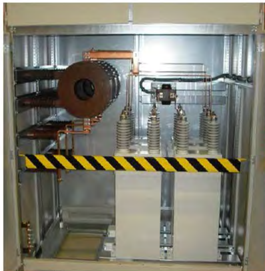
Figura 3.2.2.13 Treaptă de compensare.
