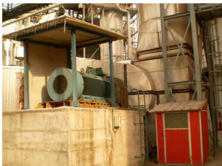
Figura 3.1.2.12 Motorul ABB de 1600kW de antrenare a ventilatorului cu J=4001 \text{ kgm}^2 (fotografie publicată cu acordul S.C. Kronospan S.A. Sebeș).
