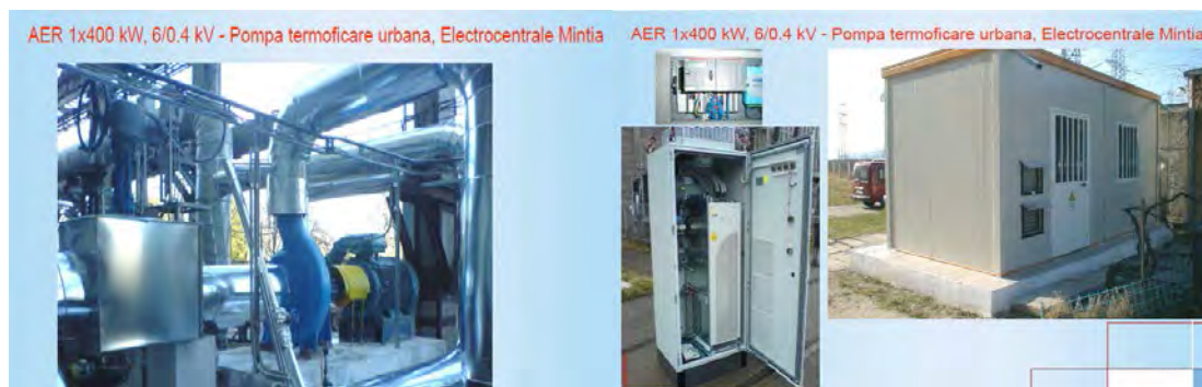
Figura 3.1.1.12 Pompa de termoficare cu turație variabilă (a) și convertizorul cu containerul pentru CSF și transformatorul uscat (b) (fotografii publicate cu acordul S.C. Complexul Energetic Hunedoara).
