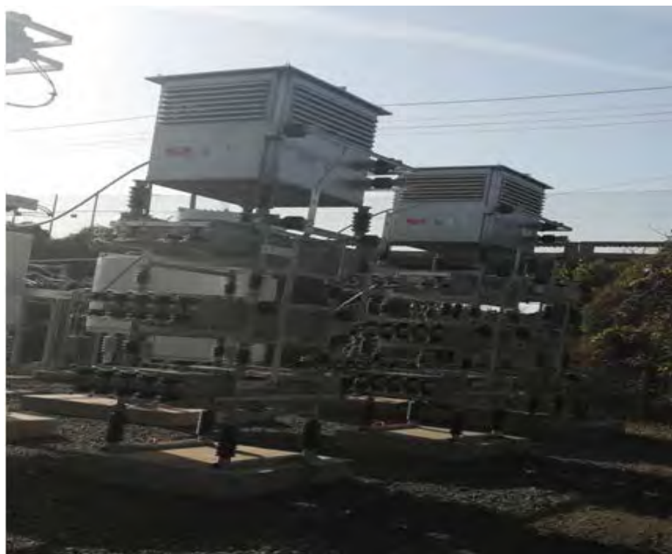
Figura 3.2.1.39 SVC-ul de la Arcelor Mittal Hunedoara (bateriile de condensatoare și rezistențele de descărcare). Fotografii publicate cu acordul SC Hidromatic SRL Timișoara.
