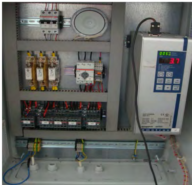
Figura 3.1.2.4 Softstarterul industrial MSF-017 folosit pentru încercările experimentale.
