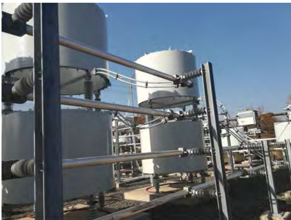
Figura 3.2.1.38 SVC-ul de la Arcelor Mittal Hunedoara (sistemul de bare și bobinele comandate de tiristoare).
