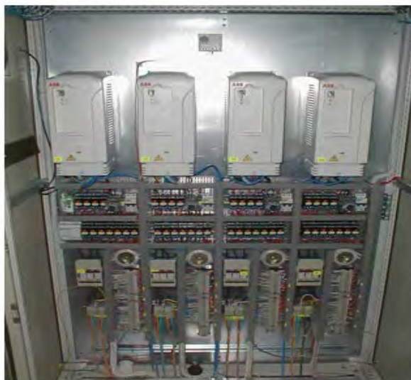
Figura 3.1.1.4 Dulapul cu CSF pentru ACB-uri la Termocentrala Mintia (fotografie publicată cu acordul S.C. Complexul Energetic Hunedoara).
