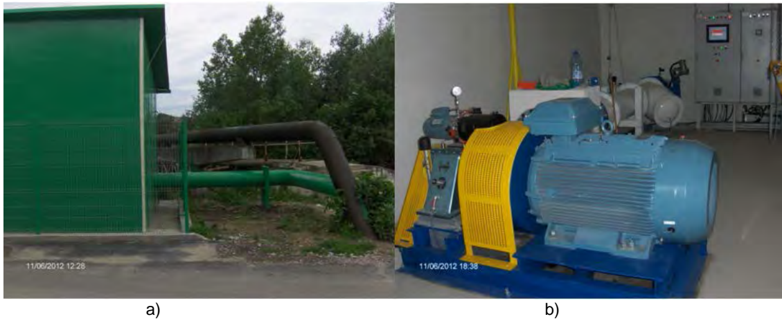
Figura 3.1.3.8 Clădirea microhidrocentralei Orăștie cu bransamentul la conducta de alimentare a stației de tratare a apei (a) și turbina Banki, generatorul asincron și panoul de comandă (b) (fotografie publicată cu acordul beneficiarului).
