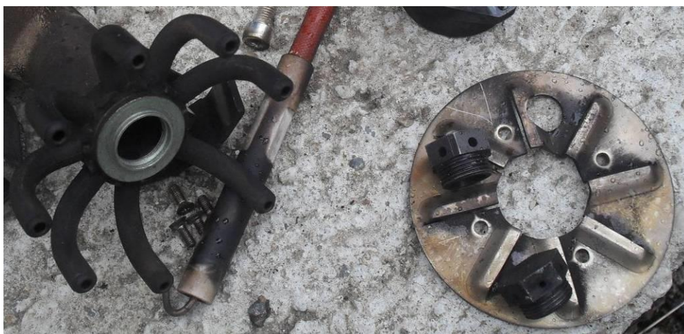
Fig. 19 – Detaliu înlocuire duză centrală arzător cu una adaptată pentru arderea biogazului
