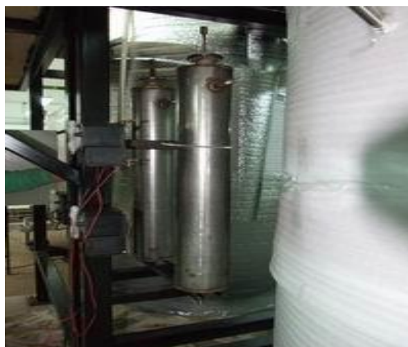
Fig. 8. - Filtrul de H 2 S (în partea din spate) și filtrul de CO 2 (în partea din față) a instalației. [1 - 11]
