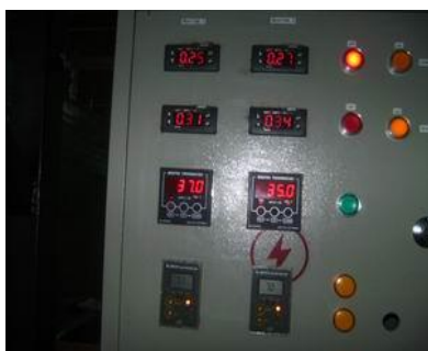
Fig. 4. – Panoul de comandă și monitorizare al instalației
