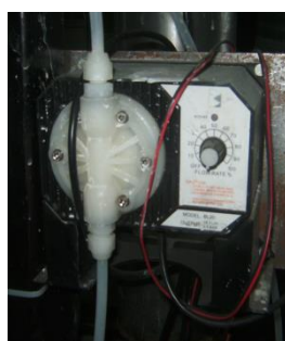
Fig. 10. – Pompă dozatoare folosită pentru spălarea biogazului [6]
