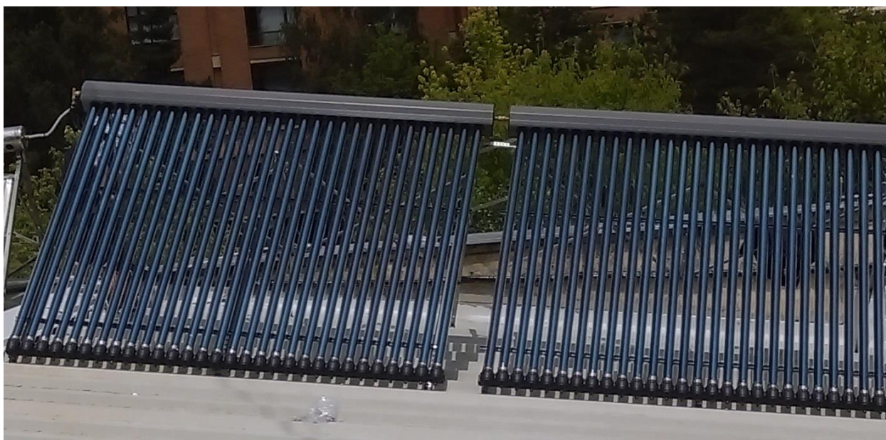
Fig 13 – Sistemul cu panouri solare montat pe acoperiș
