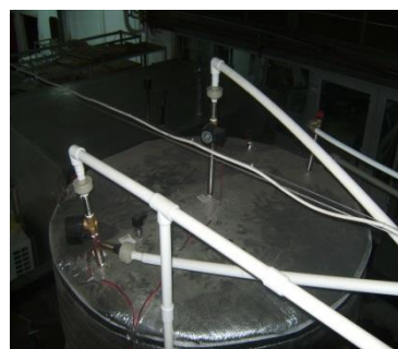
Fig. 5. – Sistemul de conducte și electroventile montat pe capacul instalației
