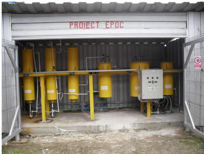
Fig. 17. – Vedere centrală a sistemului de filtrare și control
