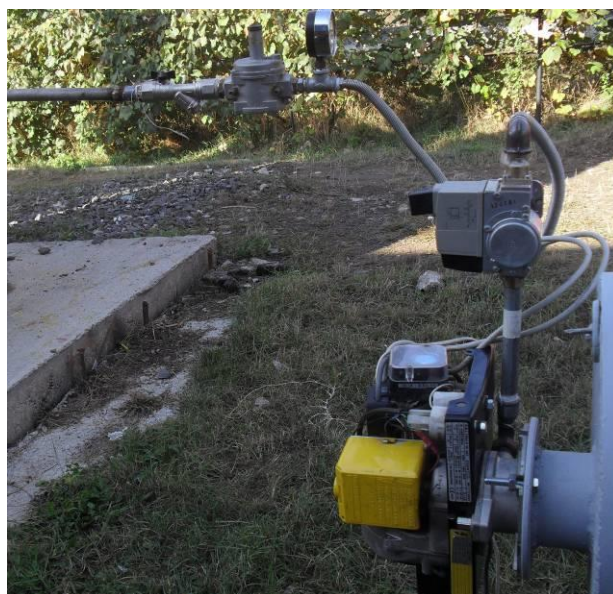
Fig. 21 – Elementele componente din cadrul montajului arzătorului
