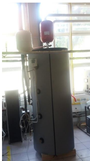
Fig 12 – Partea de amestec cu vas tampon pentru apă caldă
