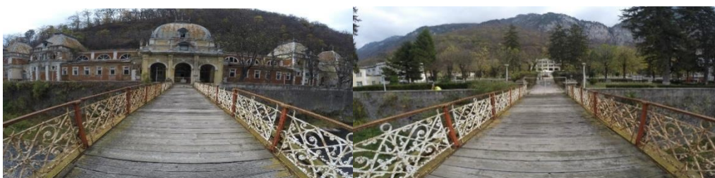
Fig 8. Starea actuala a podului
